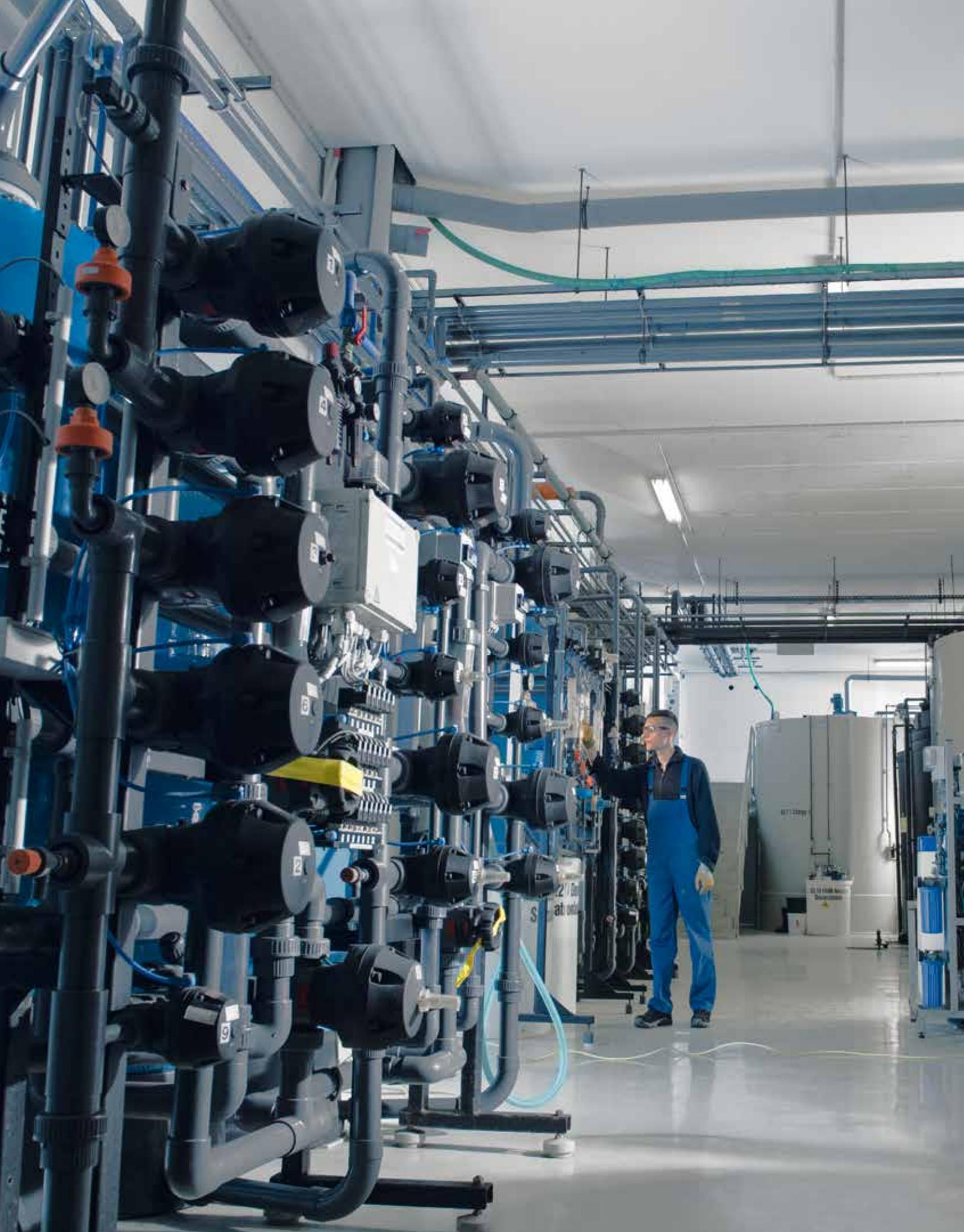
Moderne Ionenaustauschanlage zur Rückgewinnung von Metallen/Abwasseraufbereitung
