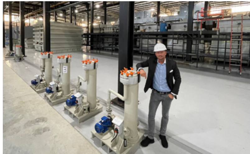
Abnahme der neuen Anlage durch den Segmentleiter der KAP Surface Holding
