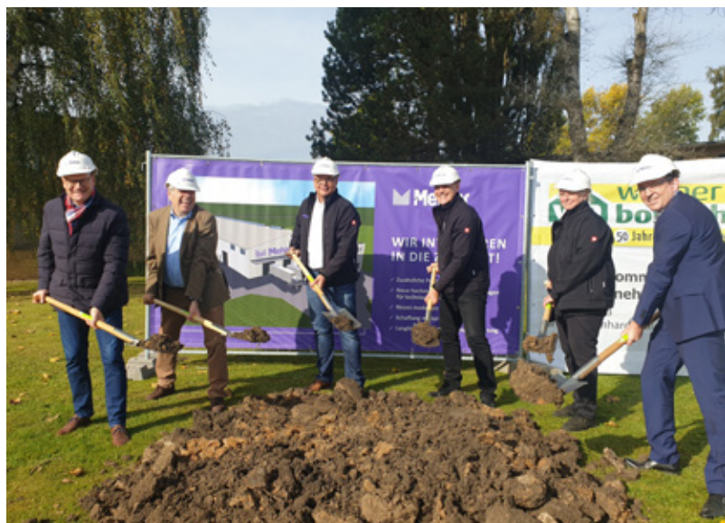
Spatenstich für den Bau einer neuen Produktionshalle mit hybrider Ausrüstungsanlage für technische Fäden am Standort Hessisch Lichtenau.
